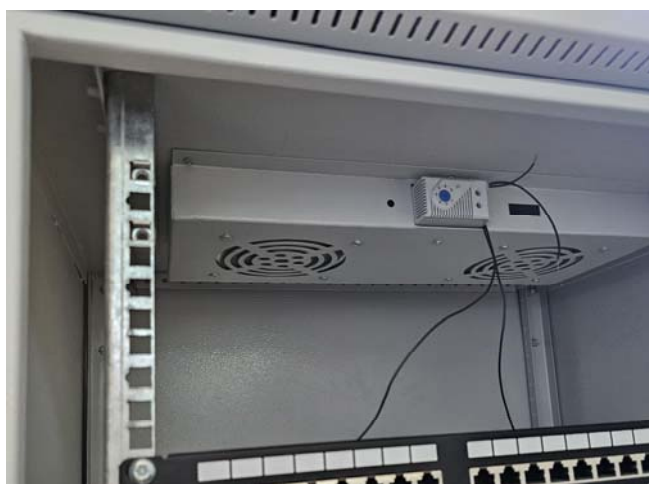
Figure 3 ventilation sur le toit
