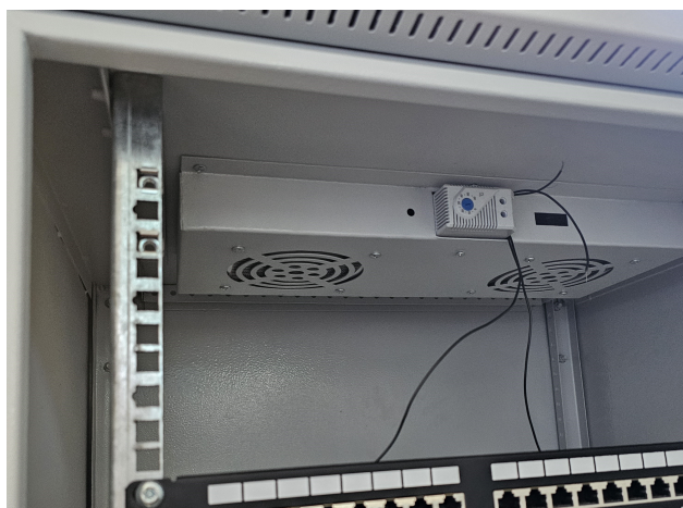
Figure 3 ventilation sur le toit
